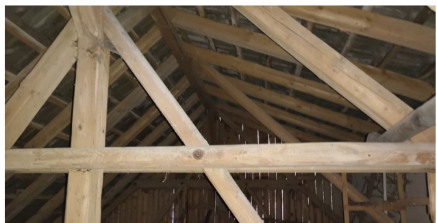
Abb. 12: Balkenlage des Schuppendaches
