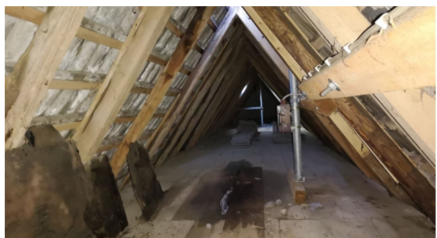
Abb. 18: Spitzboden im Oberen Dachgeschoss
