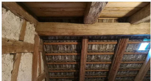
Abb. 16: Traufseite in unteren Dachgeschoss
