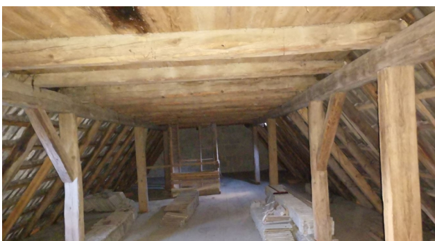
Abb. 17: Balkenlage im unteren Dachgeschoss
