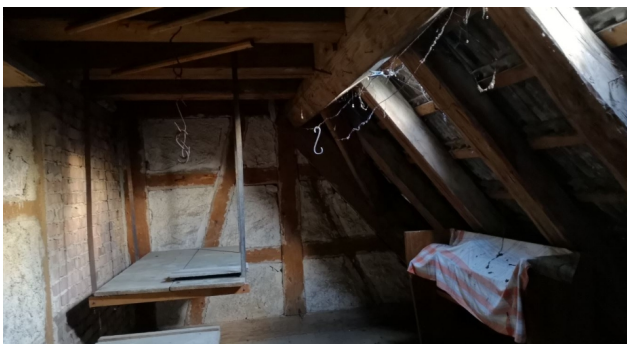
Abb. 15: Abseite im Obergeschoss
