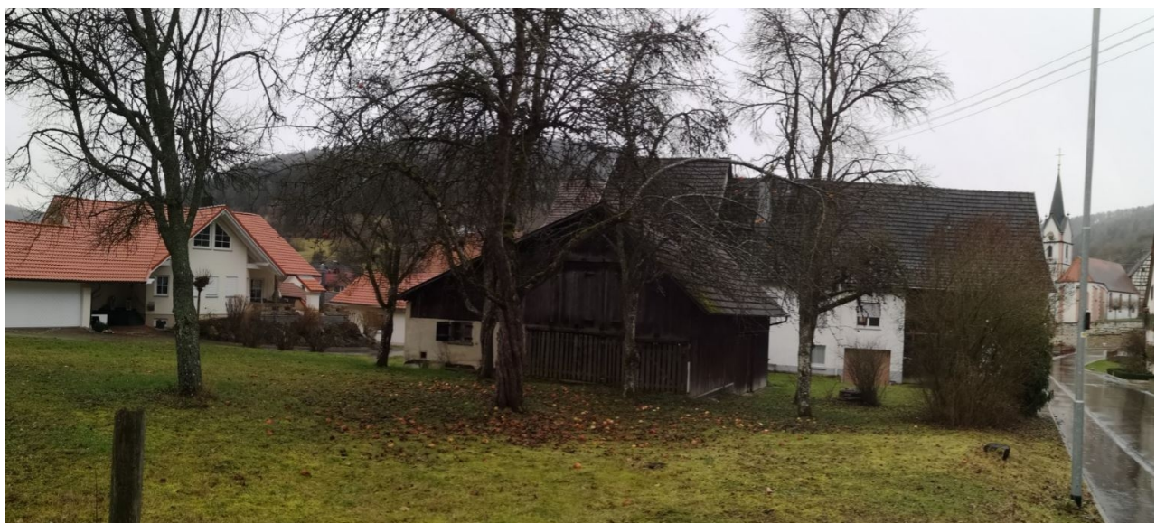
Abb. 3: Blick auf das Grundstück entlang der Bittelbronner Straße von Nordosten nach Südwesten.
